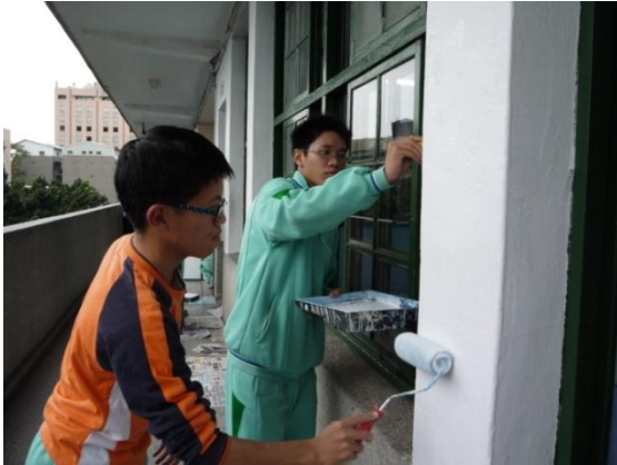
粉刷教室柱子
