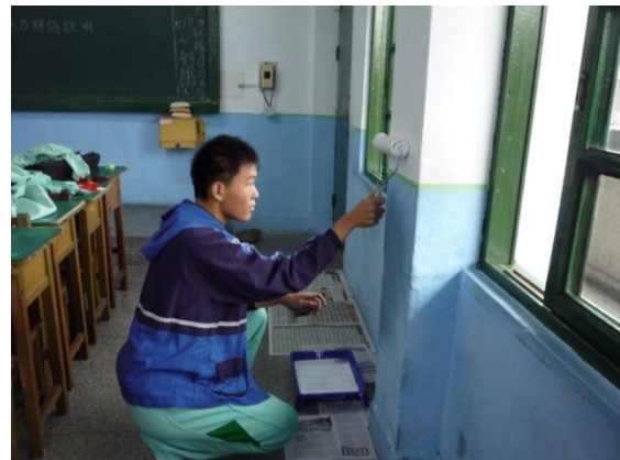
粉刷教室柱子
